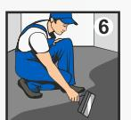
Во время заливки и последующие 7 суток температура основания и помещения должна быть не ниже +5°C. Относительная влажность воздуха должна быть выше 50%. Избегайте сквозняков на поверхности пола и в помещении в ходе работы и последние 24 часа. В течение 3 первых суток не допускайте попадания прямых солнечных лучей в помещение.
