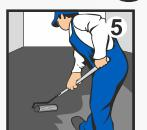
При толщине слоя свыше 5 мм установите точечные маяки для контроля уровня заливки пола. Наливной пол разлейте на поверхности полосами шириной 50-100 см. Для удаления избыточного воздуха сразу после заливки смесь прокатайте игольчатым валиком или распределите широким шпателем или раклей. Выравнивание поверхности производите за один прием, без перерывов.
